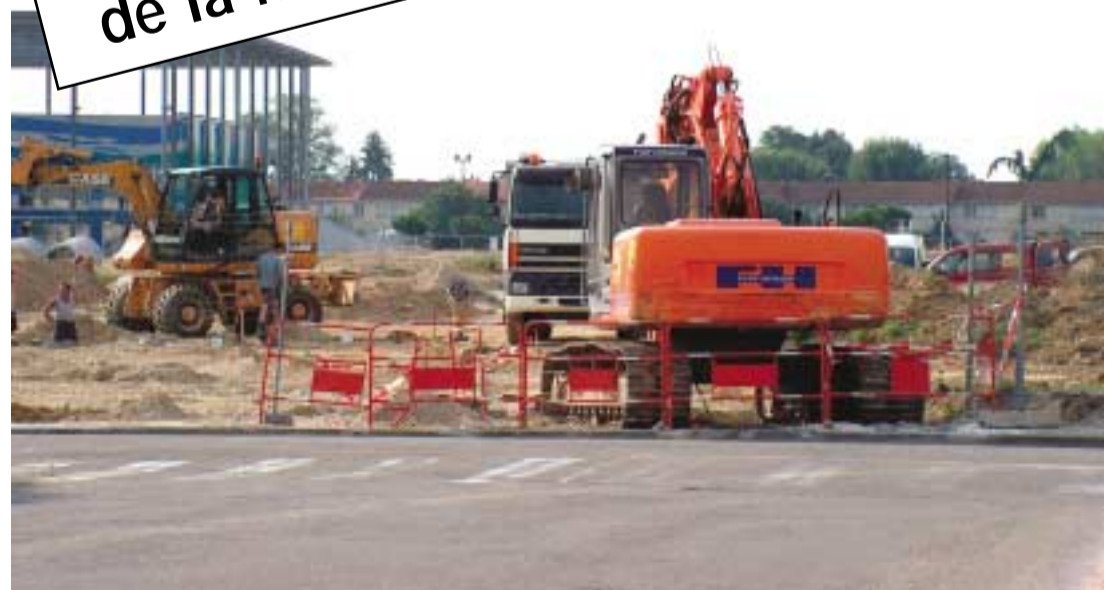
Les travaux ont bien avancé devant le centre culturel Pierre Lapoujade.
