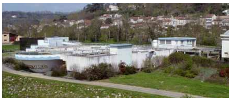
Station d'épuration à Agen
