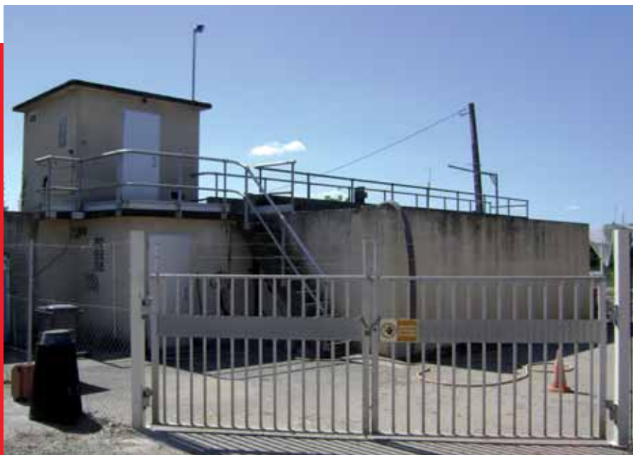
Station d'épuration Saint Hilaire : entrée
