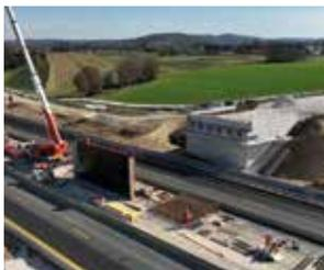
Les culées du nouveau pont sont désormais dressées en bordure d'autoroute. La construction de la pile centrale, puis la pose des poutres qui supporteront le tablier sont en cours jusqu'à mi 2022.
