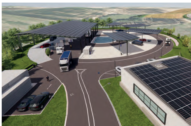
Le futur pôle de valorisation de Foulayronnes qui ouvrira ses portes en 2026 sera, comme la déchèterie de Dondas (en haut), équipé de panneaux photovoltaïques.
