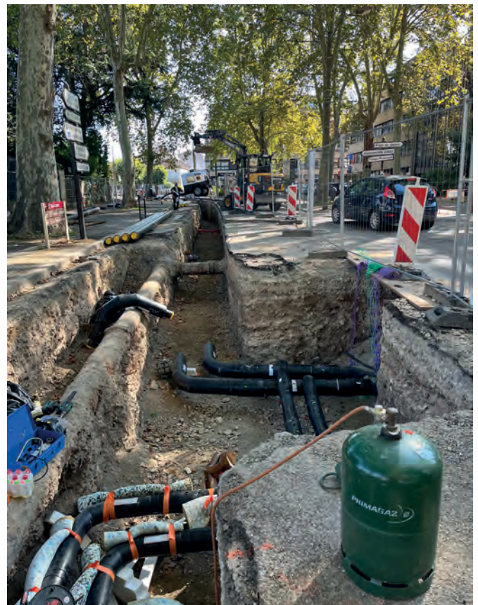
Le RCU, c'est 15,8 km de tuyaux et les rues d'Agen en chantier. Merci de votre patience !
