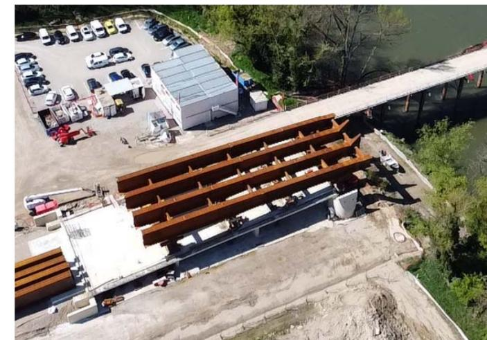
Une fois totalement assemblée, le premier tronçon de la charpente métallique sera prochainement glissé jusqu'à la première pile du futur pont.
