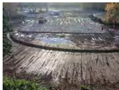
Bassin de rétention de Samazan : préparation de l'assise de digue avec précharge et drainage du fond de forme
