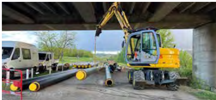
Travaux du RCU Agglomération d'Agen : stockage temporaire sous le Pont de Pierre
