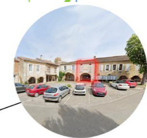
Réhabilitation de l'ancienne épicerie en salles des associations CAUDECOSTE
