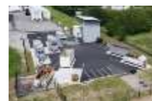
Modernisation du Carreau des producteurs locaux du MIN d'Agen-Boé BOÉ
