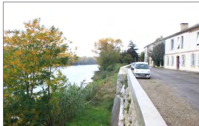
Maisons de mariniers faisant face à la Garonne - Commune de Boé
