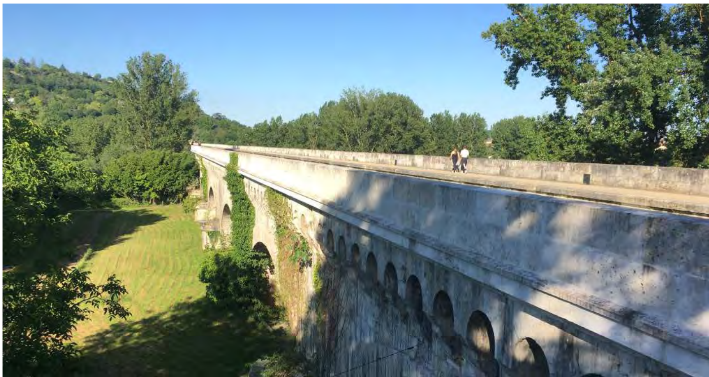
Construit au XIXe siècle et mis en service en 1849, le pont-canal constitue le fleuron des ouvrages d'art liés à la navigation en Pays de l'Agenais. Long de plus de 500 mètres, reposant sur pas moins de 22 piles, construit en pierre de taille du Quercy, il permet à la navigation du canal latéral de franchir la Garonne dans la continuité du centre historique d'Agen. Sa traversée met en scène les paysages du fleuve, des coteaux et le patrimoine bâti de la ville en bord du cours d'eau.
