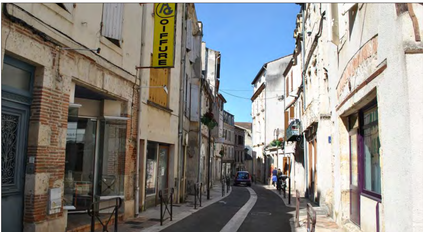
La rue Richard Cœur de Lion présente plusieurs habitations vacantes à la façade dégradée
