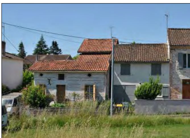
Maisons de marinières alignées en bord de Garonne. Ces constructions de faible hauteur (en général R+ 1) sont contiguës et forment un ensemble homogène de qualité lié au passé navigable du fleuve. Le Passage-d'Agen
