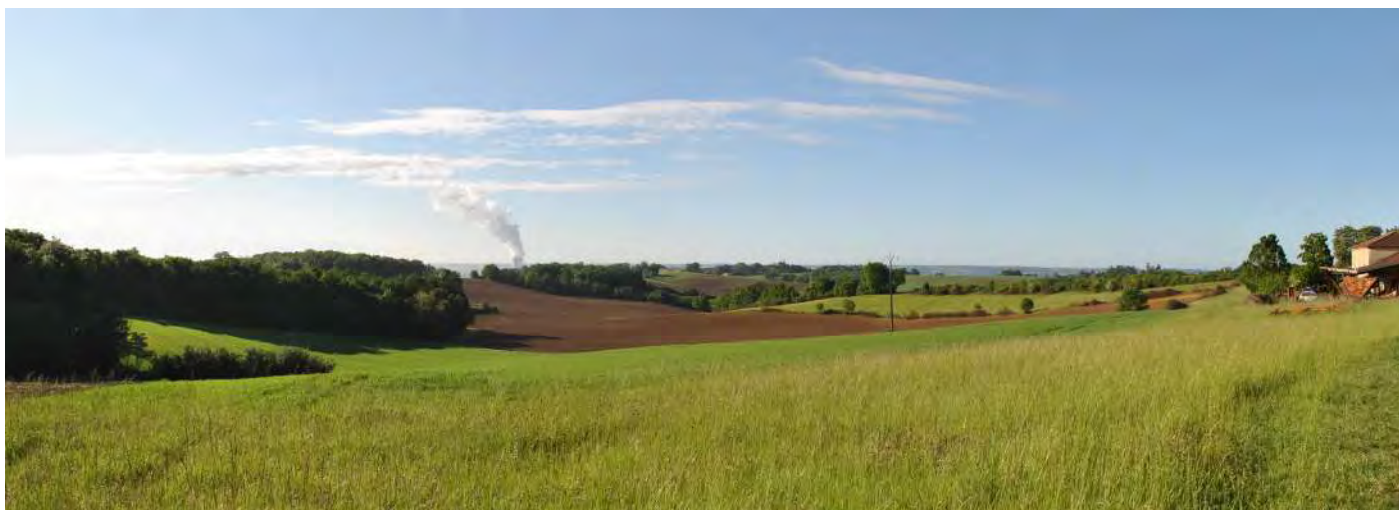
La centrale nucléaire vue depuis le Pays des Serres, Saint-Romain-le-Noble
