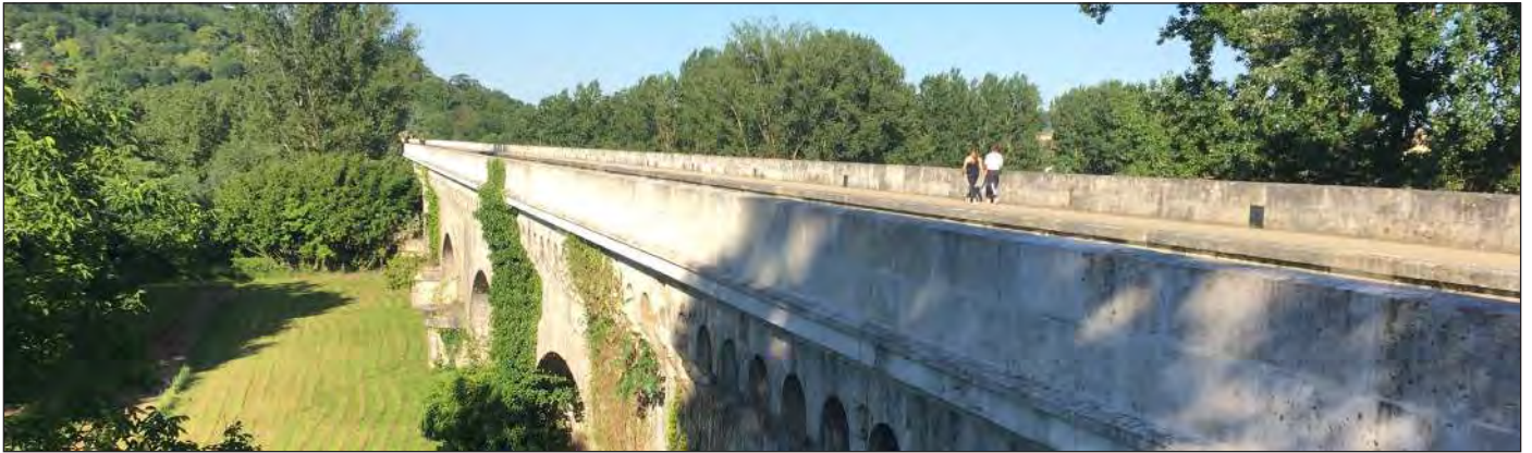
Pont-canal, pont construit au XIX e siècle qui permet au canal latéral de la Garonne de franchir le fleuve et ainsi de relier l'Océan Atlantique à la mer Méditerranée
