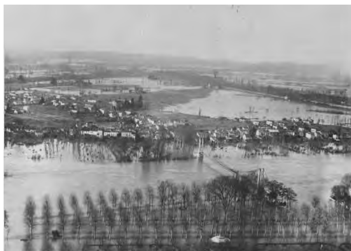
L'esplanade du Gravier et les habitations du Passage d'Agen inondées lors de la crue de 1930 à Agen
