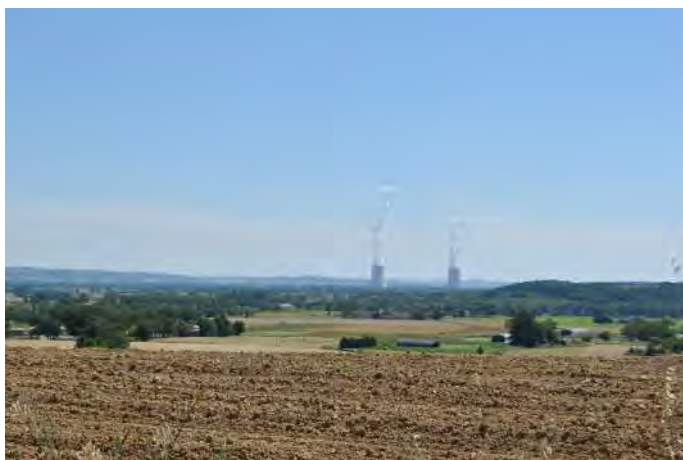
La centrale électrique vue depuis la vallée de Garonne, Caudecoste
