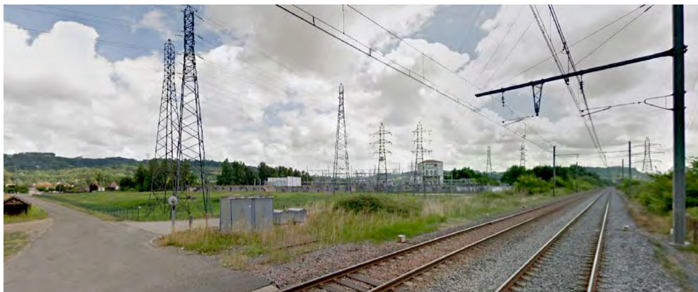
Par endroit, la profusion de pylônes HT et postes électriques portent atteinte aux paysages emblématiques de la vallée de Garonne, notamment les coteaux boisés : effacement/enterrement des réseaux aériens, traitements des abords des postes électriques
