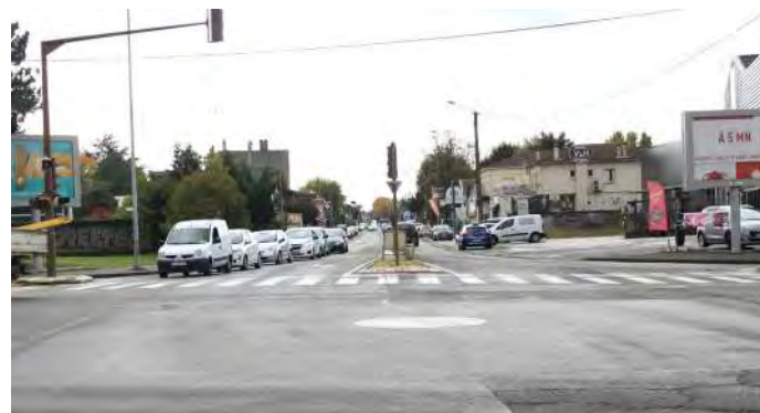
Vastes emprises grises, bétonnées et imperméabilisées, absence de végétation pour adoucir le caractère routier de la RD813 au niveau de Bon-Encontre
