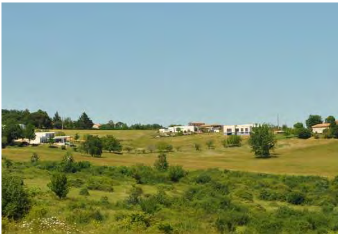
Constructions sur les crêtes et dans la pente sur la commune d'Aubiac
