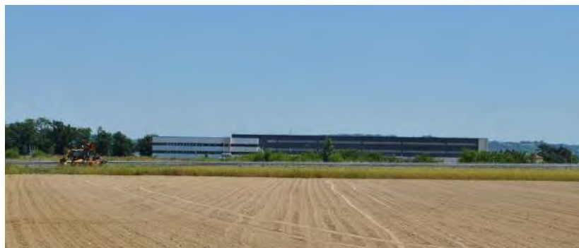
Transition brutale et sans relation entre un des premiers bâtiments du Technopole Agen-Garonne, l'A62 et les terres agricoles, Sainte-Colombe-en-Bruilhois
