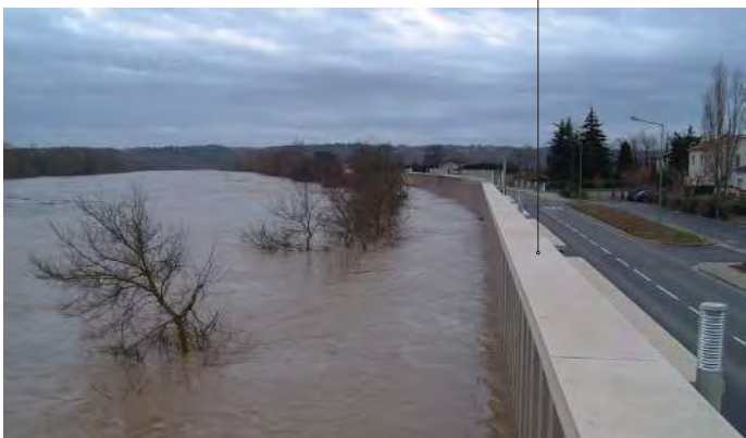
En cas de crue, ces ouvrages contiennent la montée rapide des eaux et protègent les espaces urbanisés, ici lors de la crue 2003 à Agen
