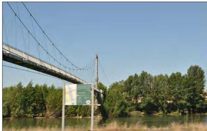
Passerelle piétonne sur la Garonne - Commune d'Agen
