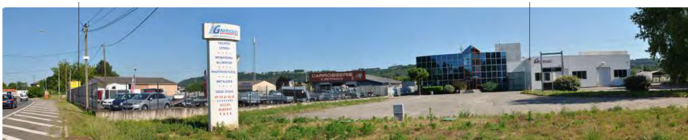
Clôtures, pylônes électriques et mats d'éclairage peu qualitatif
