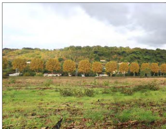
Implantation du village de Saint-Jean-de-Thurac sur les pentes du coteau
