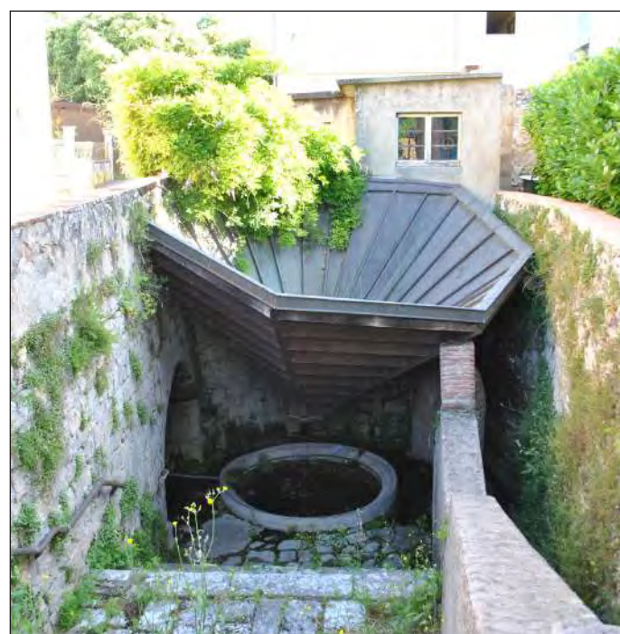
Lavoir en zinc - Commune de Layrac
