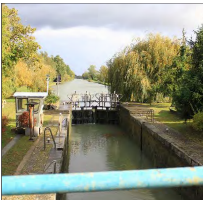
Écluse présente le long du canal latéral de la Garonne - Commune de Saint-Jean-de-Thurac
