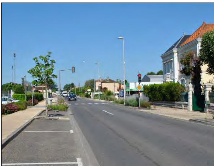
Façades des maisons donnant sur la RD813 - Commune de Colayrac-Saint-Cirq
