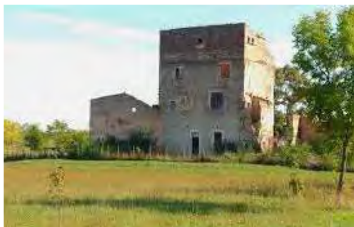
Bel exemple de valorisation : création du projet «Maison de Garonne», son centre d'interprétation avec la rénovation de la Tour Lacassagne à Boé
