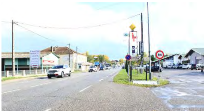
Absence de voies pour les mobilités douces, profusion d'enseignes publicitaires hétéroclites et de mobilier routier, zones de stationnement minéralisées... Ces éléments constituent la première image que le visiteur se fait d'Agen
