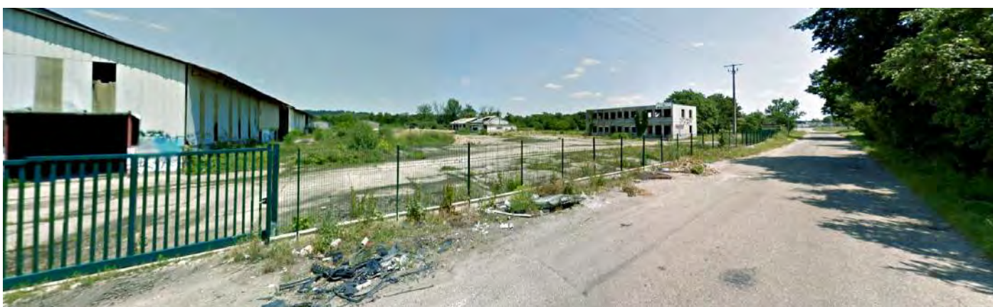
Les friches économiques : encourager la reconversion des friches d'activités ou industrielles et la requalification architecturale des bâtiments d'activités et de leurs abords : couleurs, matériaux, enseignes, dé-minéralisation de sols et végétalisation, plantations... ,zone industrielle de Brimont, Boé
