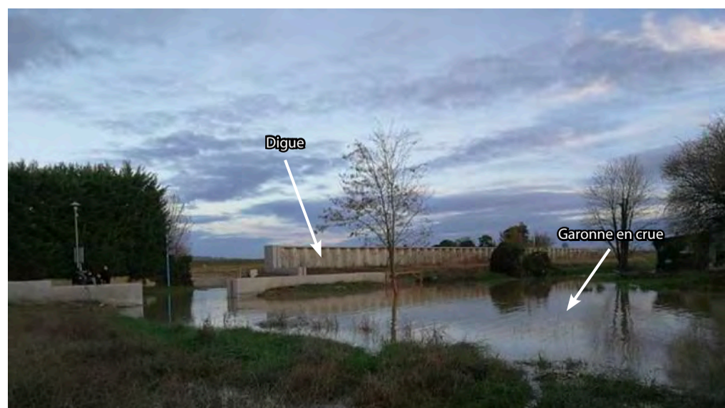
Boé, une commune exposée aux aléas et risques de crue de la Garonne (source : Commune de Boé)
