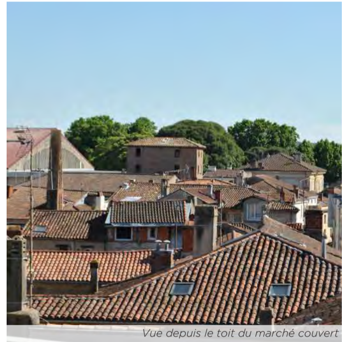
La rue Richard Cœur de Lion présente plusieurs habitations vacantes à la façade dégradée
